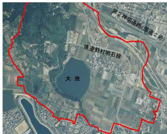
写真1 現況航空写真
